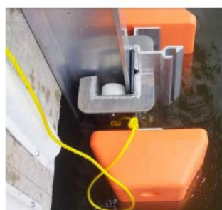
Рисунок Г.6 - Устройство для предотвращения утечек между бонами и стенкой причала
